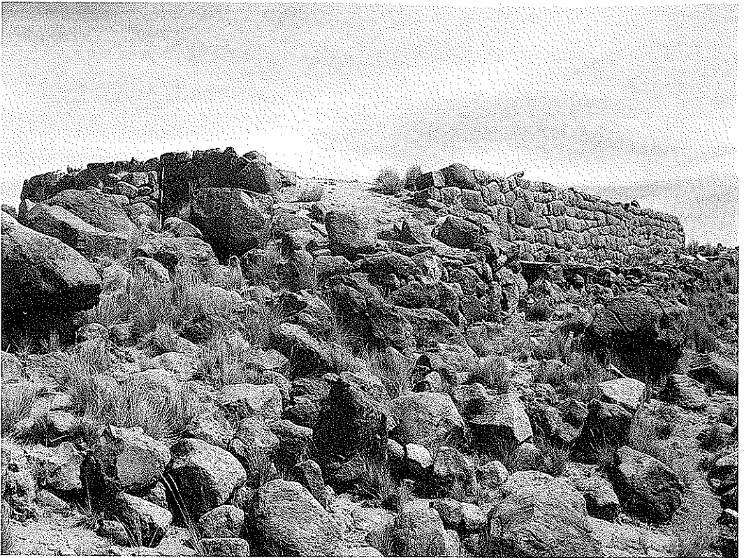
Fig. 16: Ushnu de Conoca Orqo, ubicado en el distrito de Sacsamarca en Huancasancos, presenta acabado de tipo inka imperial. (Foto: Yuri Cavero Palomino)
