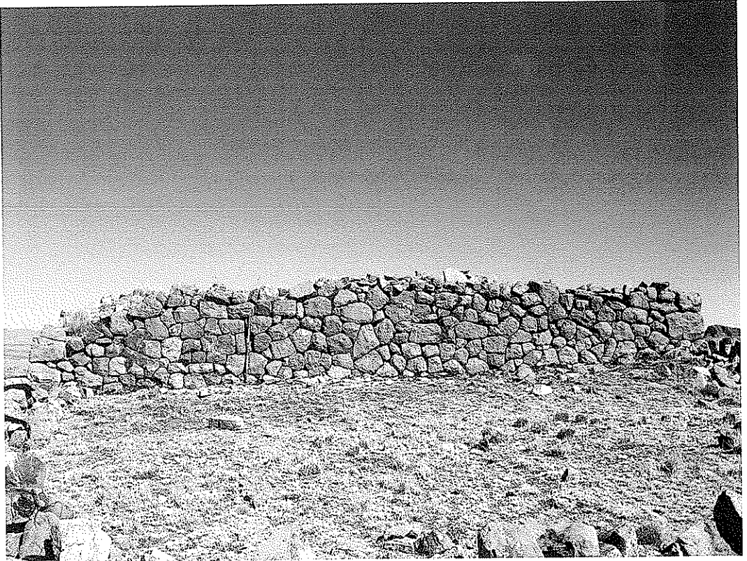
Fig. 20: Ushnu de Parionaqocha, en la provincia de Víctor Fajardo. Obsérvese el acabado simple o tipo pirqa que presenta sus muros (Foto: Yuri Cavero)
